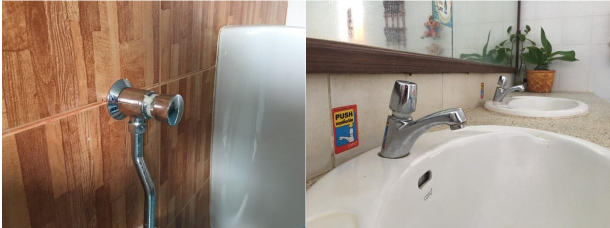
ภาพที่ 1 แสดงการใช้เคเบิลไทร์รัดบริเวณปุ่มกดก๊อกน้ำเพื่อลดปริมาณการไหลของน้ำ
