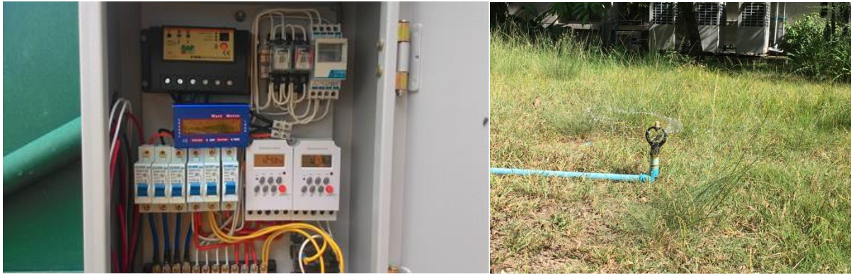
ภาพที่ 2 แสดงการนำพลังงานไฟฟ้าโซลาร์เซลล์มาควบคุมการเปิด-ปิดอุปกรณ์การรดน้ำแบบอัตโนมัติ
