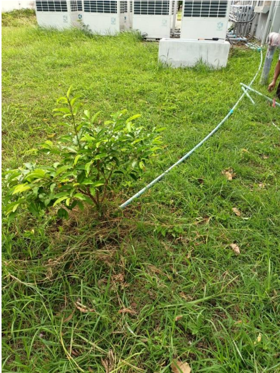
ภาพที่ 4 แสดงการนำน้ำทิ้งจากเครื่องปรับอากาศไปรดน้ำต้นไม้
