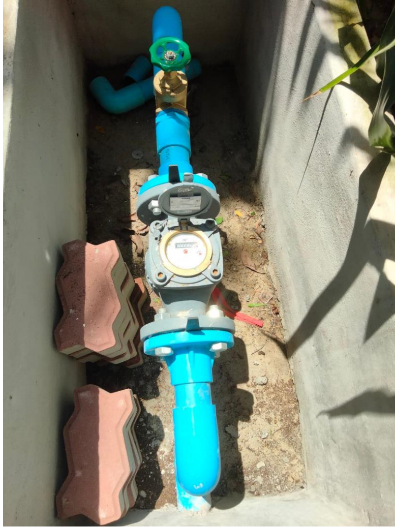
ภาพที่ 2 แสดงการติดตั้งมิเตอร์น้ำ อาคารหอสมุดจอห์น เอฟ เคนเนดี (อาคาร 17)
