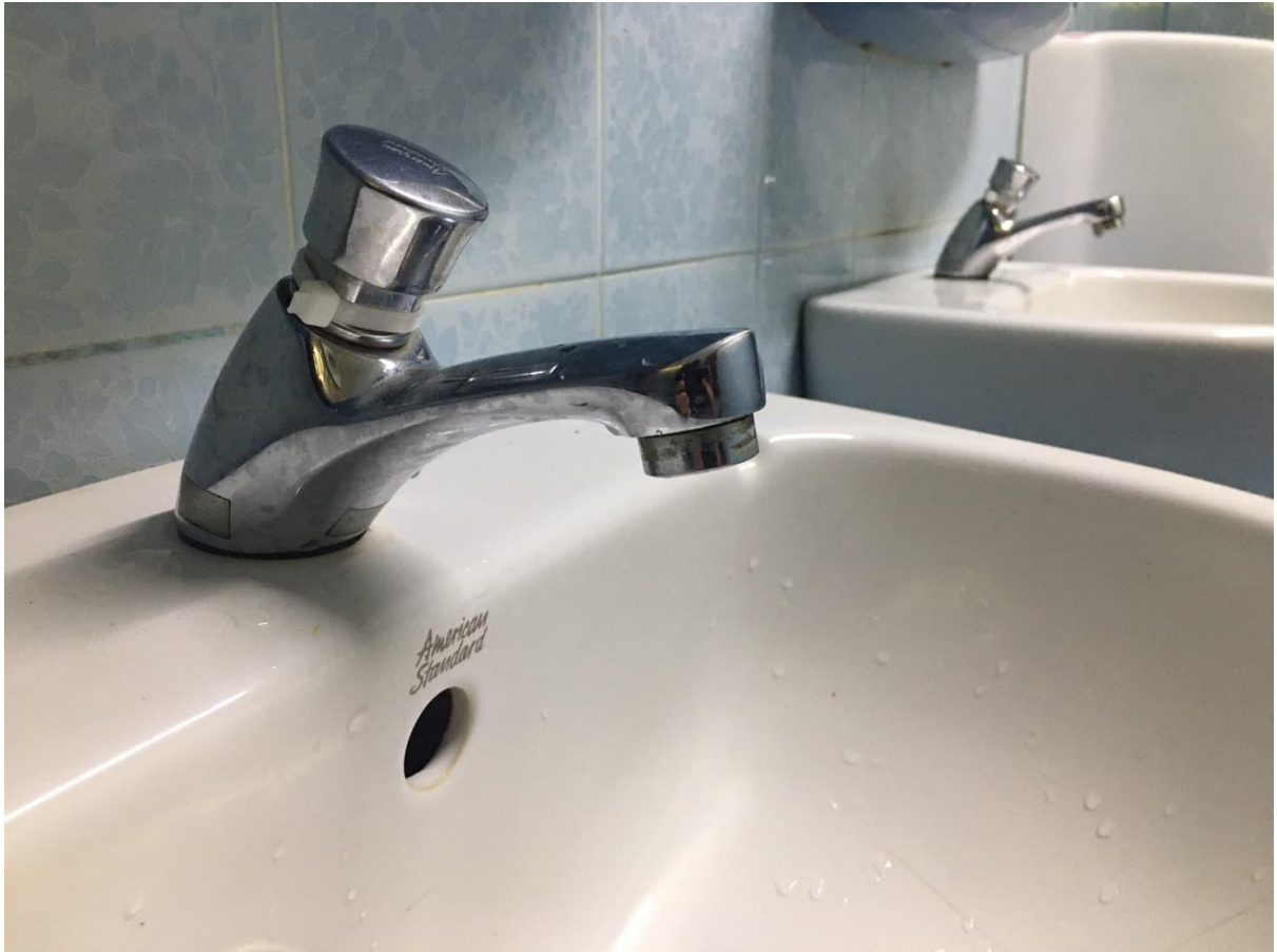
ภาพที่ 5 แสดงการติดตั้งเคเบิลไทร์เพื่อจำกัดการไหลของน้ำ
