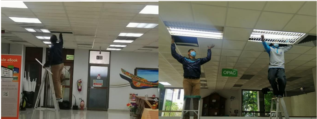
ภาพที่ 2 การเปลี่ยนหลอดไฟ LED ขนาด 18 วัตต์
