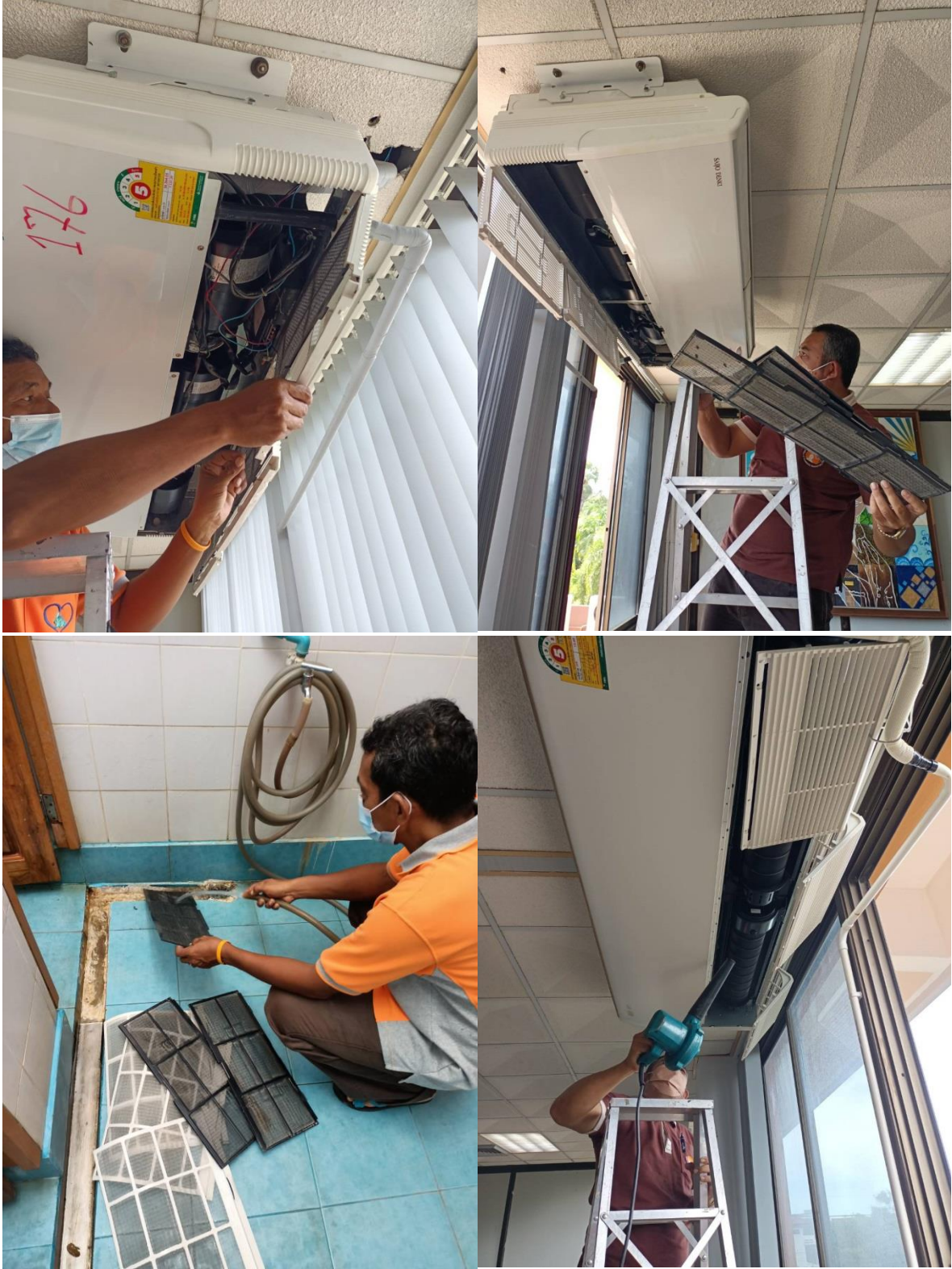
ภาพที่ 1 แสดงการทำความสะอาดเครื่องปรับอากาศ
