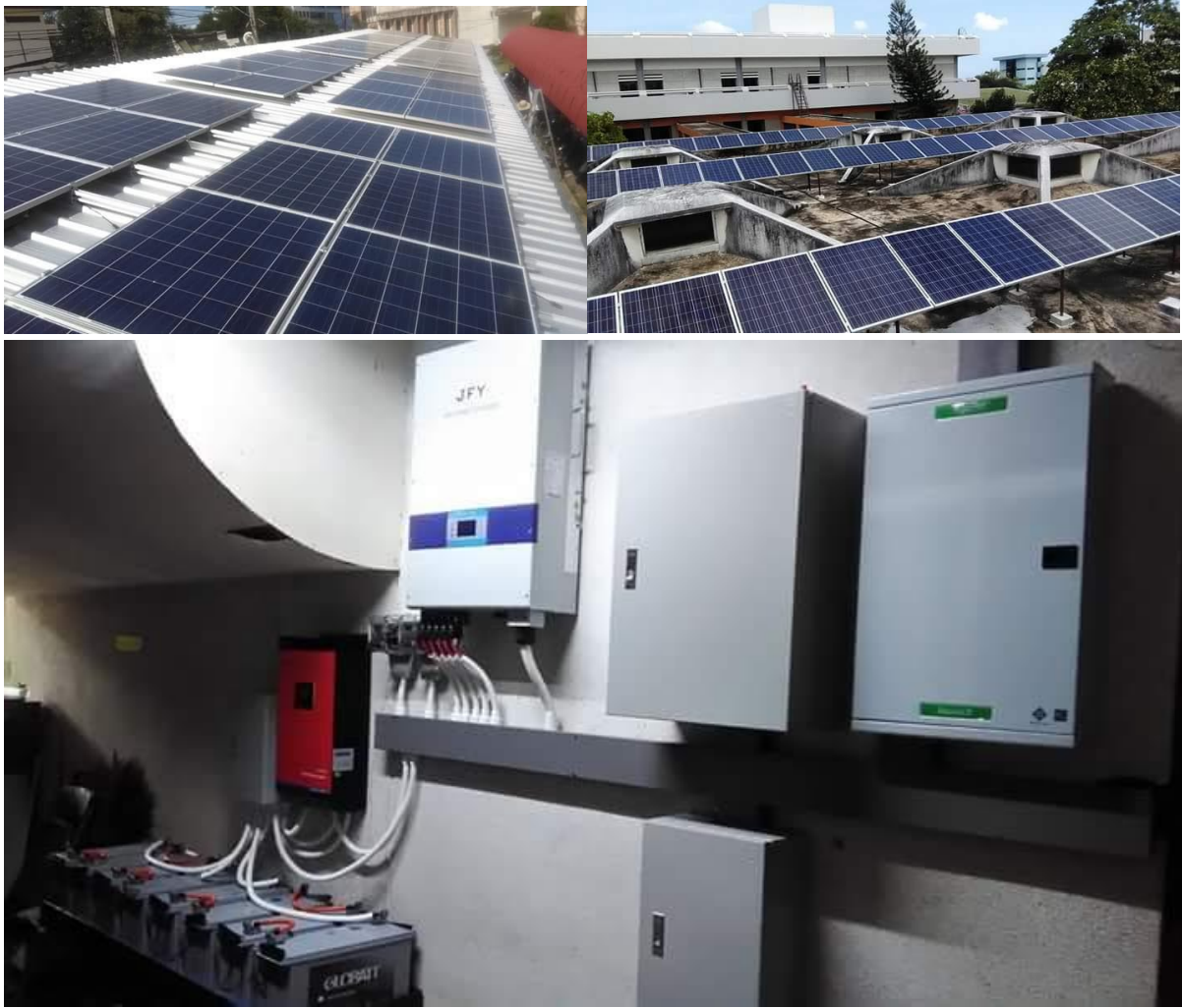
ภาพที่ 5 การใช้พลังงานไฟฟ้าโซลาร์เซลล์ทดแทนการใช้พลังงานไฟฟ้าจากสายส่ง
