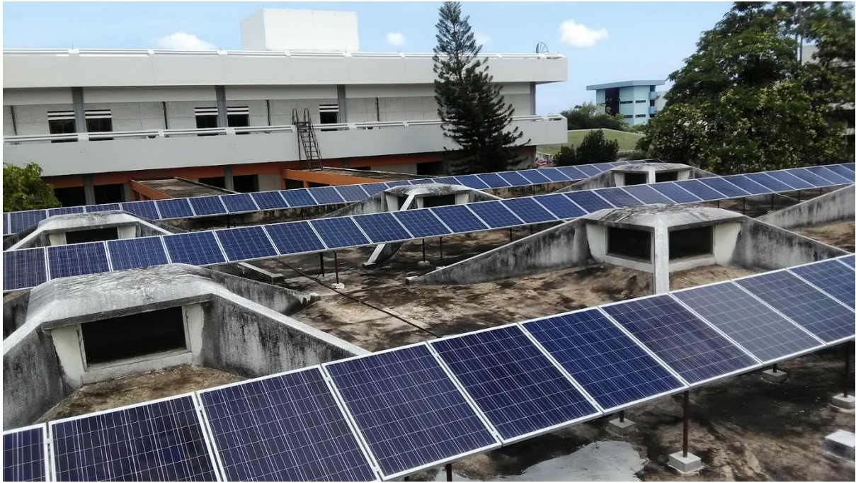
ภาพที่ 6-8 แสดงการติดตั้งระบบไฟฟ้าโซลาร์เซลล์ของอาคารหอสมุด จอห์น เอฟ เคนเนดี
