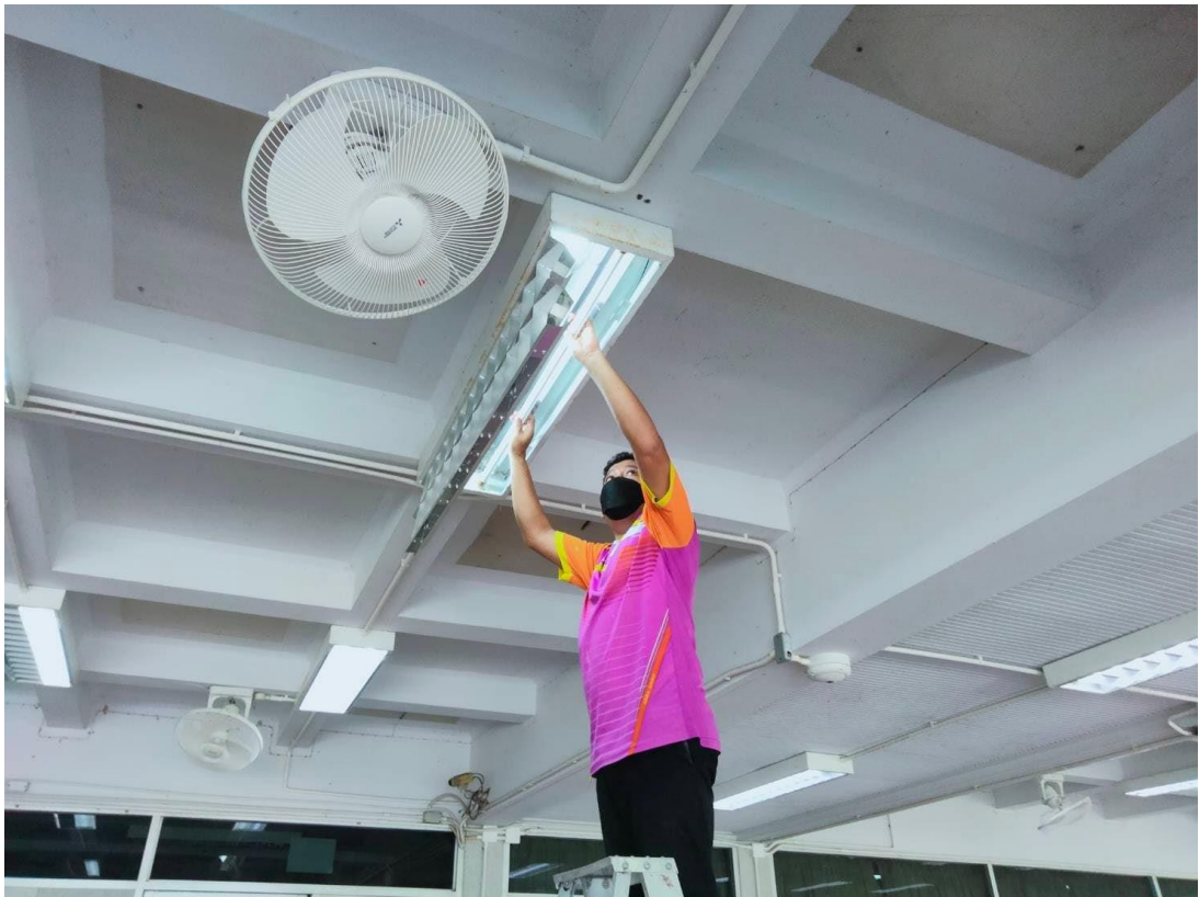
ภาพที่ 3-4 แสดงการเปลี่ยนหลอดไฟฟ้าเป็นแบบ LED
