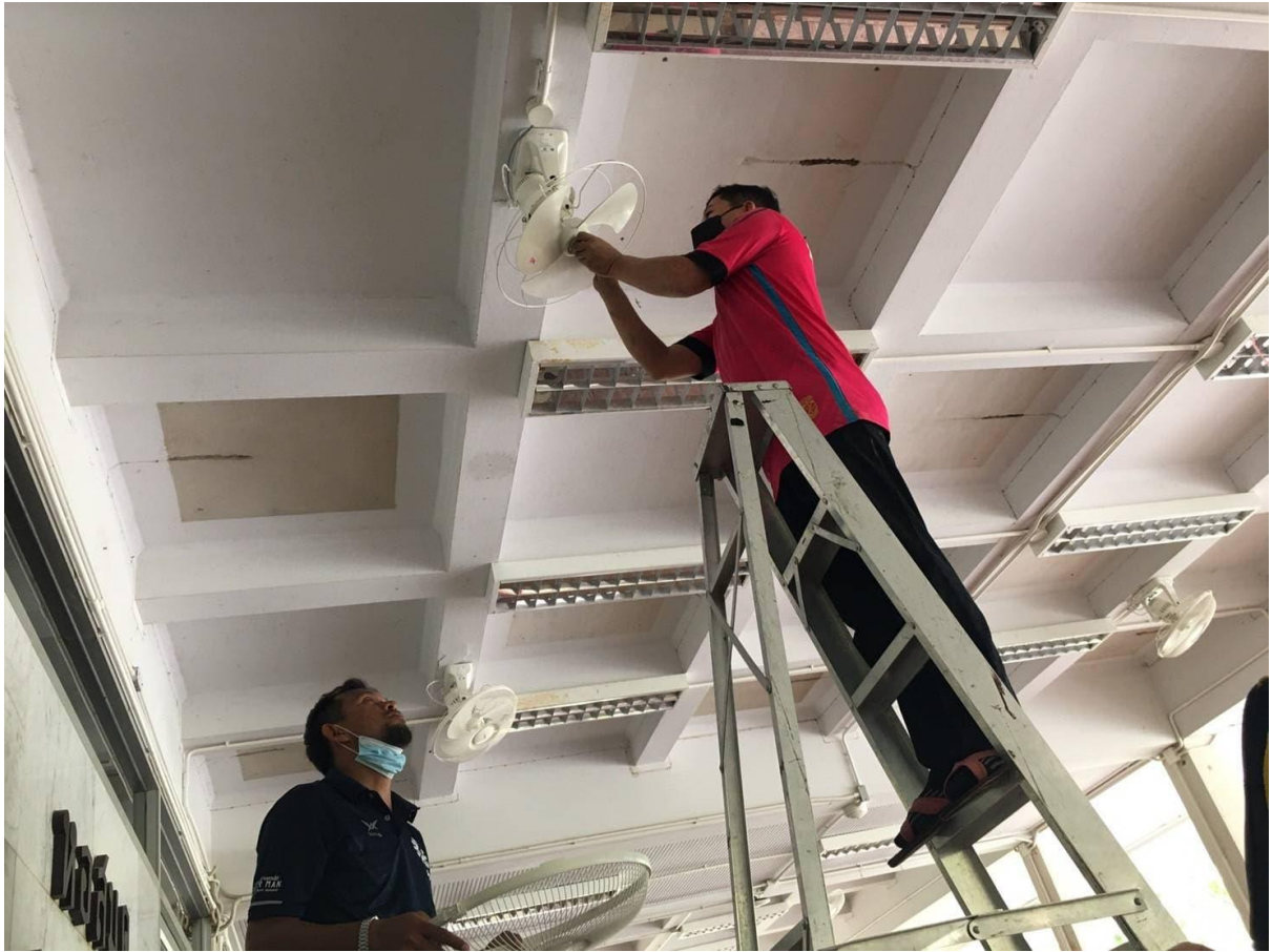
ภาพที่ 5 แสดงการเปลี่ยนอุปกรณ์ไฟฟ้าเป็นแบบประหยัดไฟ เบอร์ 5
