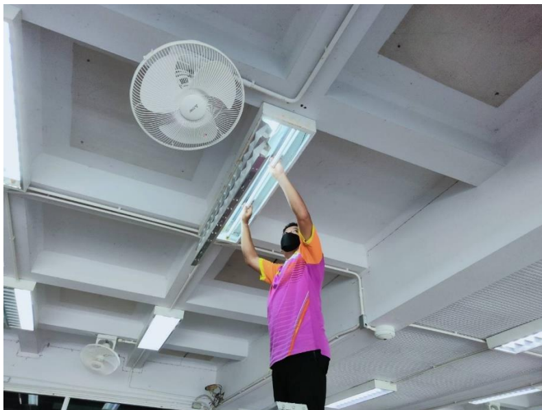
ภาพที่ 10 การตรวจเช็คซ่อมแซมหลอดไฟฟ้าแสงสว่าง
