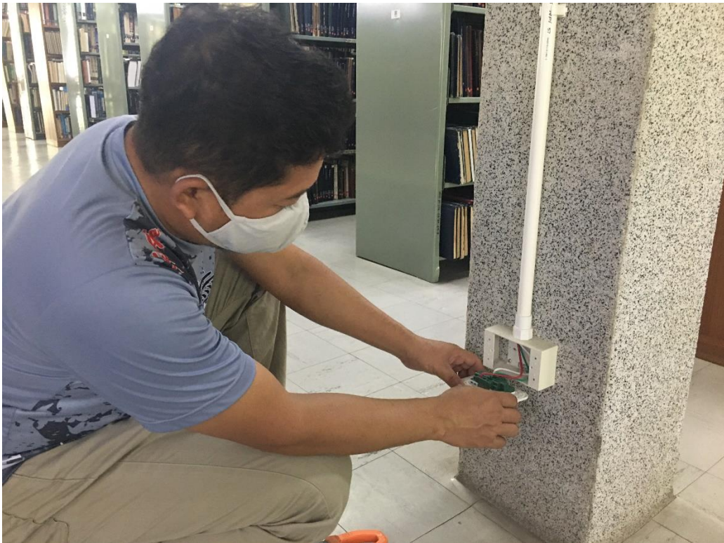
ภาพที่ 12 การตรวจเช็คเต้ารับไฟฟ้า
