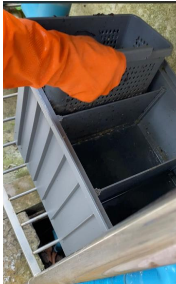
ภาพการทำความสะอาดถังดักไขมัน
