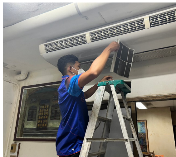
ทำความสะอาดแผ่นกรองอากาศเครื่องปรับอากาศ
