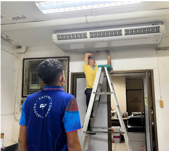
ทำความสะอาดแผ่นกรองอากาศเครื่องปรับอากาศ
