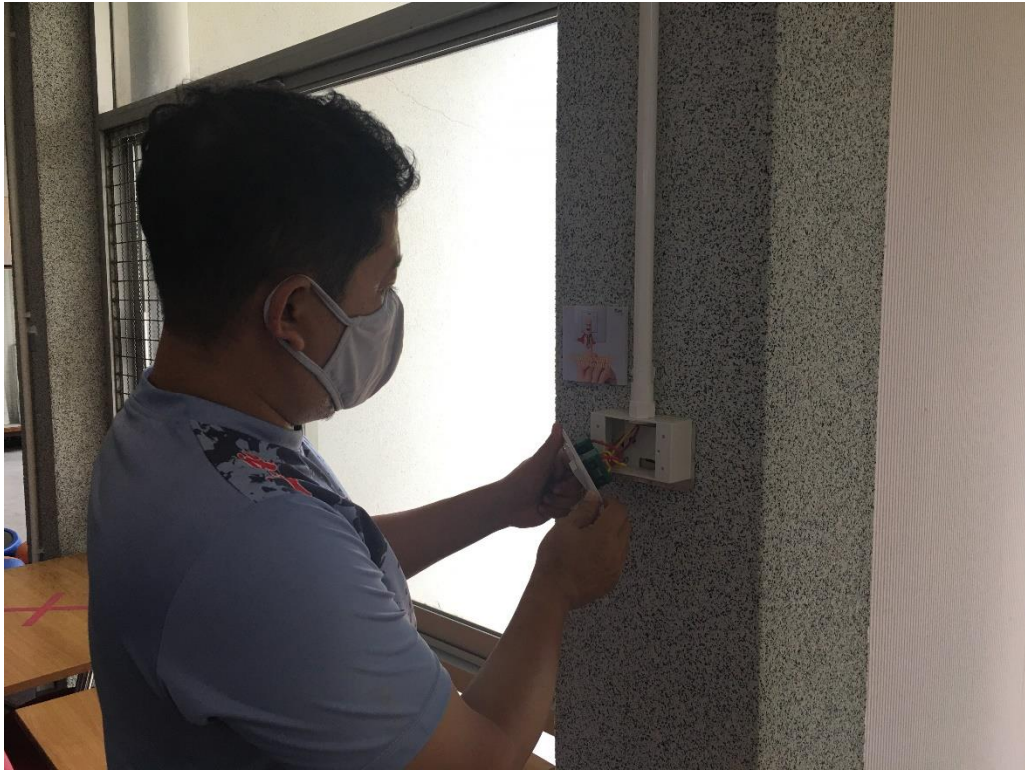
ภาพที่ 11 การตรวจเช็คสวิทซ์ไฟฟ้า
